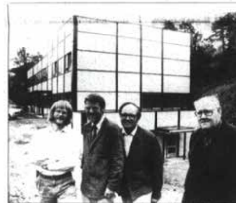
Barbu Menighetshus på Nyli er ikke bare blitt dobbelt så stort. Det fremstår også i ny drakt etter en omfattende oppussing. Prestekontorer er det også blitt plass til etter utvidelsen, og det er Lv. klokker Jan Egil Hagli, res.kap. Svein Gjesdal, sogneprest Olav Alsåker og kirketjener Alf E. Nilsen glade for.
